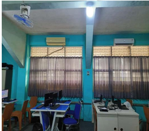
Gambar: Foto Alat di ruangan Sumber : Penulis
